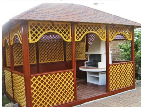
Решётчатые элементы придают ажурность беседке с вальмовой крышей, покрытой мягкой черепицей.
