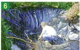
3 Уже можно увидеть окончательную форму будущего водоёма. Подготовленную чашу облицовывают плёнкой.
