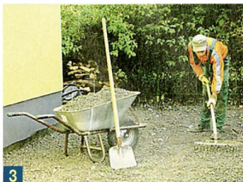
1 Для «подушки» под плитку требуется щебёнка размером фракциями 5–30 мм.
