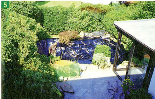
1 Сформированное основание пруда с песчаной подложкой накрывают нетканым полотном,...
