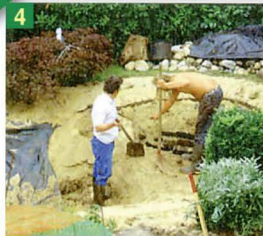
4 Прежнюю дамбу в центре пруда откапывают, убирают и приступают к формированию...
