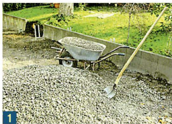
1 Для «подушки» под плитку требуется щебёнка размером фракциями 5–30 мм.
