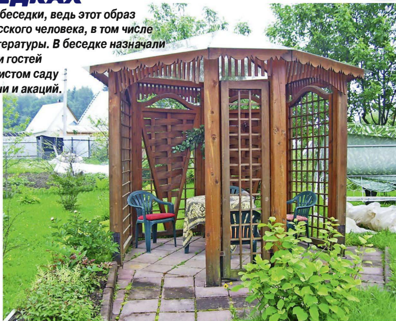
Открытая беседка с крышей из поликарбоната. Стойки-опоры из бруса 150x150 мм, между стойками установлены стенки-решётки и ветрозащитные экраны.
