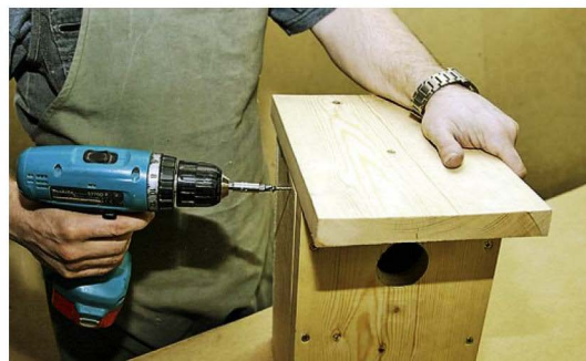
6 Вставьте крышку в корпус скворечника и закрепите её с боковых сторон.
